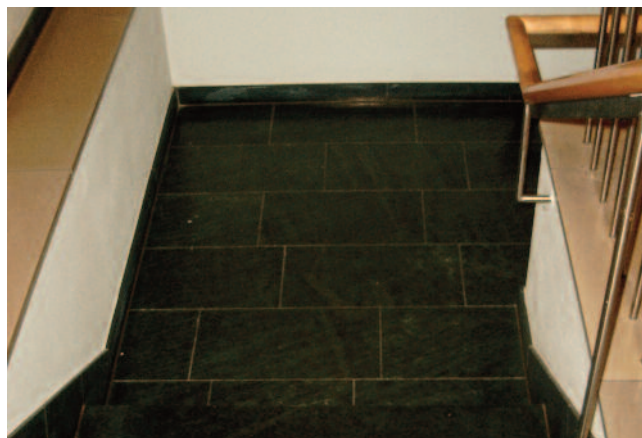
Gefahrenstelle Treppe: Stufen sind oft nicht erkennbar und somit besonders für schlecht sehende und sehbehinderte Menschen gefährlich.
