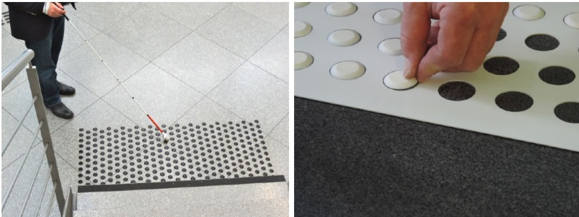
Foto links: Aufmerksamkeitsfeld und Stufenmarkierung an einer Treppe (inclusion AG/LVR Köln). Rechts: Leitsystem wird mithilfe einer Schablone verlegt. Die Rückseite der Elemente ist mit Klebstoff beschichtet, vor der Montage muss lediglich die Schutzfolie entfernt werden.
