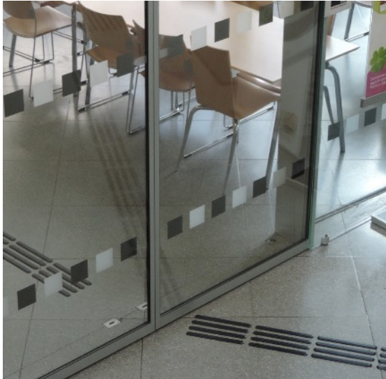
Foto links: Glasmarkierungen können einfach und schnell nachgerüstet werden (inclusion AG/LVR Köln). Rechts: Gebogene Handlaufmarkierung aus Aluminium mit Relief- und Brailleschrift (rückseitig).
